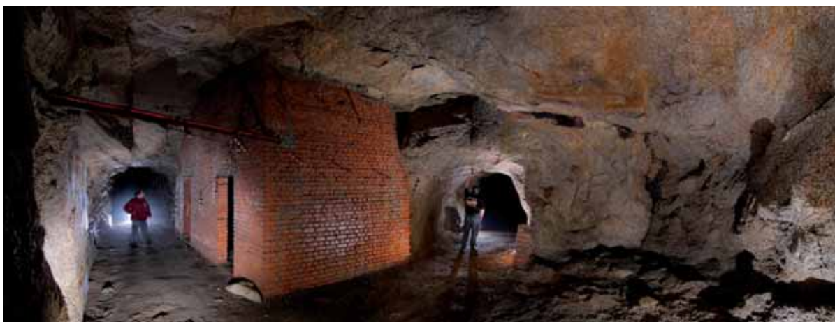
Obr. 6: Vlevo výrobní hala, vpravo jižní přístupová chodba. V místě cihlové instalace dosáhla hala svého plného budoucího profilu šířky 6 metrů. Foto: Martin Přibil, Jerzy Kotwak.
