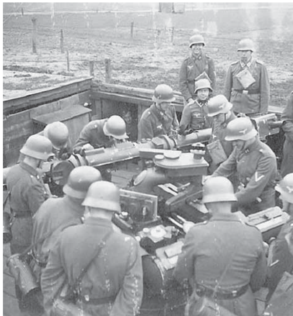
Obr. 3: Kommandogerät 40, zaměřovací a povelový přístroj s výpočtem předstihu obsluhovalo 5 mužů a velitel. Zařízení vybavené analogovým počítačím stroj řídilo palbu baterií flaku na cíl. Foto – sbírka autora.
