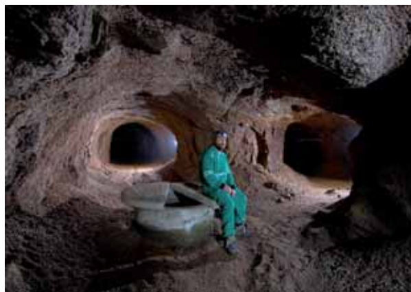
Obchoz kolem nevybudované protivýbuchové hráze severní vstupní chodby podzemní továrny FAB. Foto: Martin Přibil.
